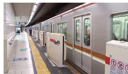
田園調布駅東横線ホームに設置されたホームドア
